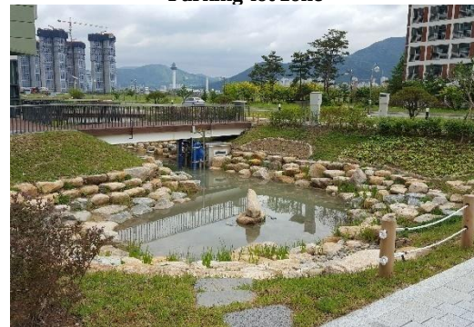
Bioretention LID zone
